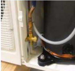
Bild 19: Serviceventil vätskeledning
