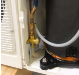
Bild 19: Serviceventil vätskeledning
